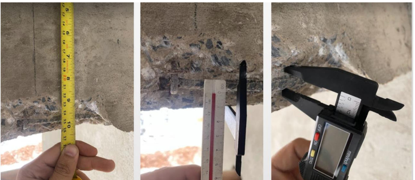
Abertura de janela de inspeção e aferição do cobrimento e diâmetro das armaduras – Fonte o Autor (2024)
